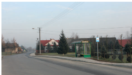
Budowa chodnika w Łąckie Dolnej
