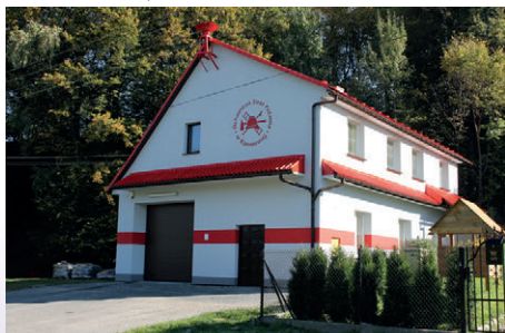
Remiza w Kamionnej po termomodernizacji
