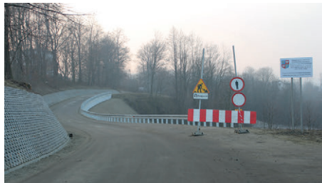
Zabezpieczenie i stabilizacja osuwiska w Ujeździe
