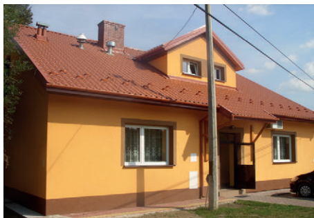
Remiza OSP w Łąckiej Dolnej po remoncie
