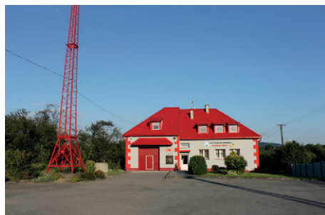
Efekty termomodernizacji Remizy OSP w Ujeździe
