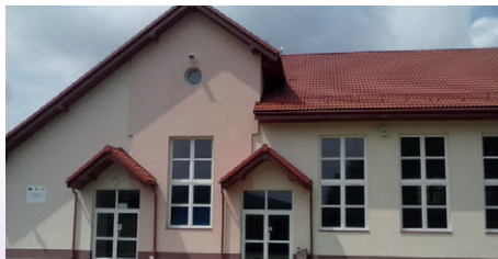
Sala gimnastyczna w Kamionnej
